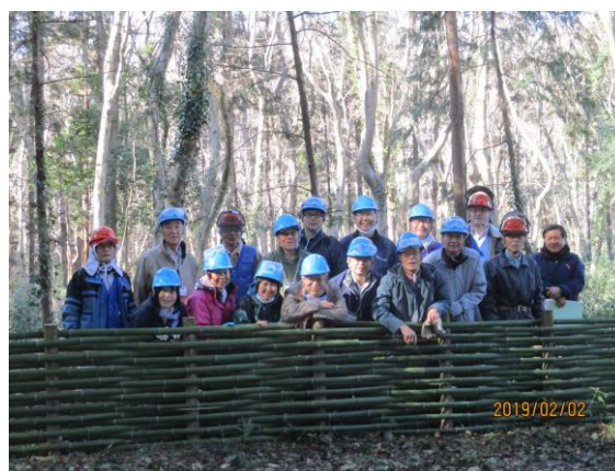
第3日：防護柵補修の完成
